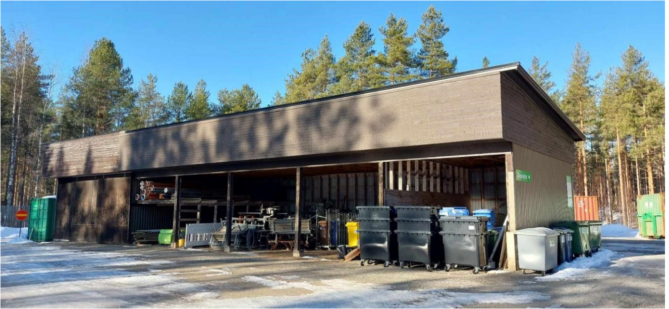
Kuva 21. Kunnan varikko/Jäteasema, Kuortintie 138.
