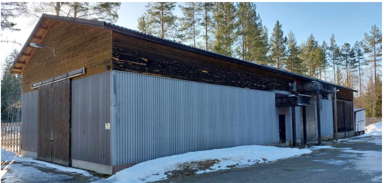
Kuva 20. Kunnan varikko/Jäteasema, Kuortintie 138.
