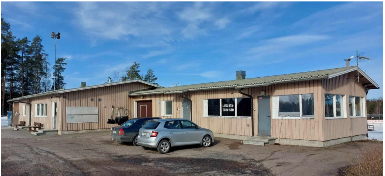
Kuva 67. Huoltorakennus, Mäntyharjun urheilualue. Kuvan rakennuksen kunto heikko.
