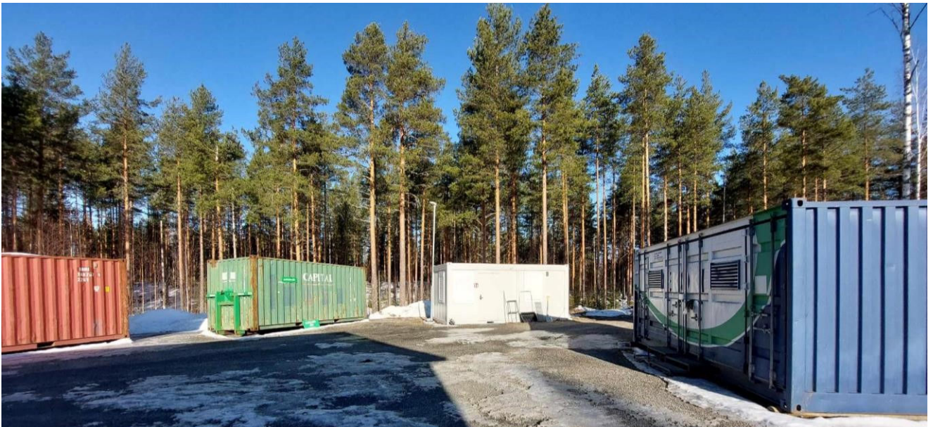
Kuva 22. Kunnan varikko/Jäteasema, Kuortintie 138.
