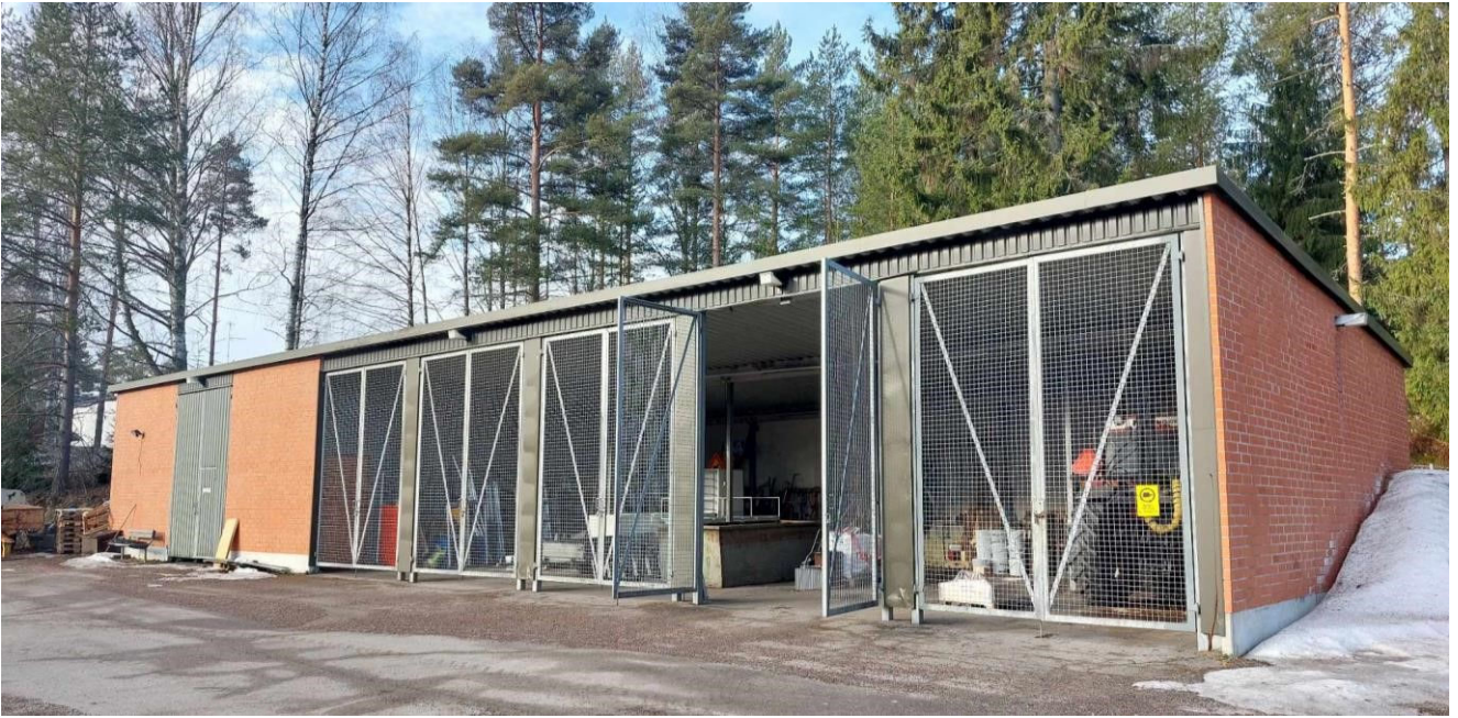
Kuva 8. Teknisen varikon varastorakennus.
